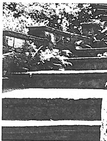
Fig. 5.5.k. Natuurstenen trap met afgedekte wangen, tevens keermuur.
