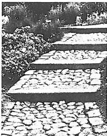
Fig. 5.5.h. Natuursteen treden met opvulling van zerfstenen.
